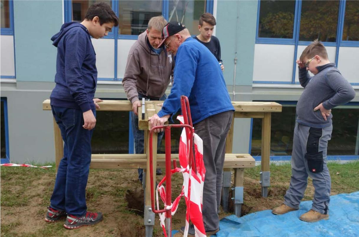
Nach dem präzisen Einpassen wird alles mit Schnellzement vergossen
